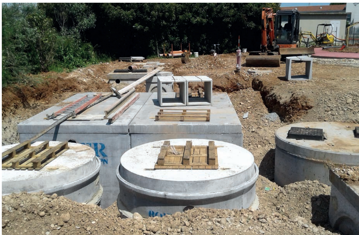
Fasi di installazione di un impianto a fanghi attivi doppia linea.
